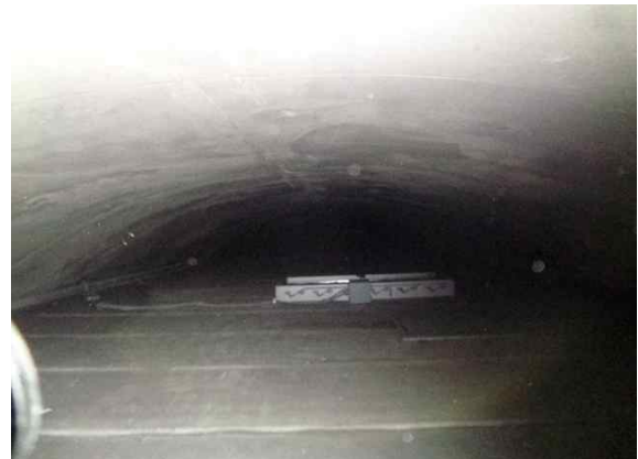
성산방향 풍도슬래브 내부 전경
