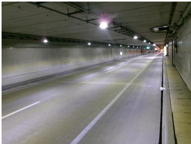
서부간선지하도로 내부 (BOX구간)
