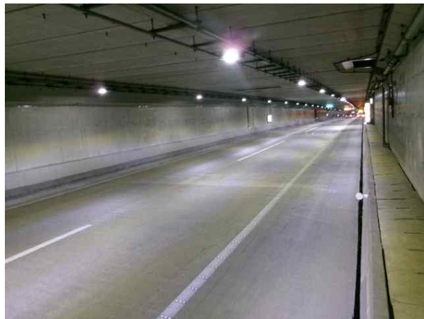
서부간선지하도로 내부 (BOX구간)
