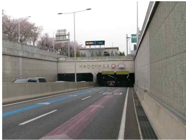
서부간선지하도로 성산방향 진입부
