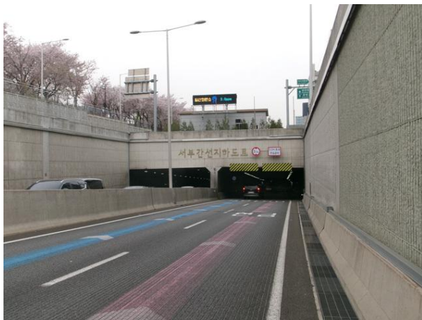
서부간선지하도로 성산방향 진입부
